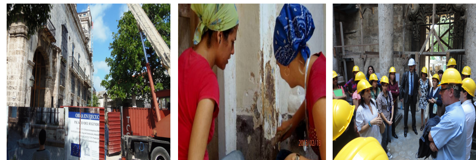
En proceso constructivo de la obra/Visita Delegación de la UE
