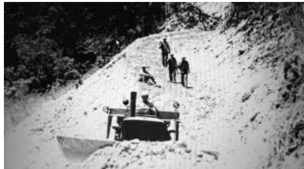
Trabajos de terraceo con equipos pesados.
