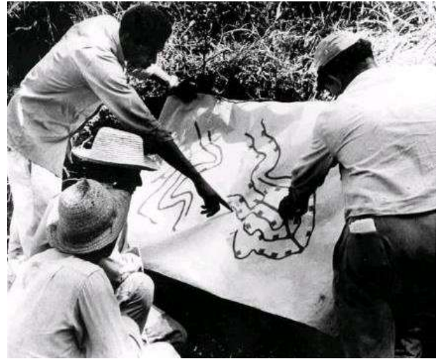
Trabajadores en el replanteo del poblado, septiembre de 1968.
